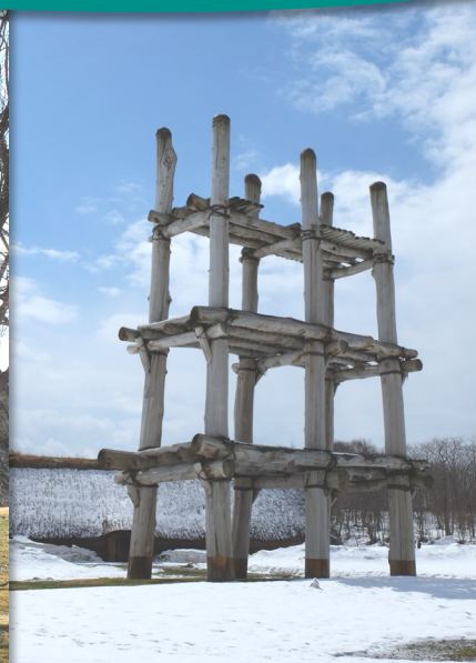
三内丸山遺跡大型掘建柱建物
